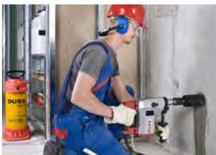
DOSENSENKEN in Beton – nass, handgeführt
