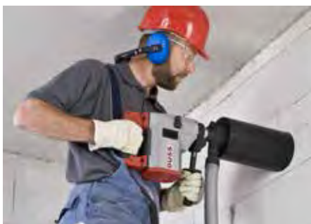
TROCKENBOHREN IN MAUERWERK mit Staubabsaugung – handgeführt
