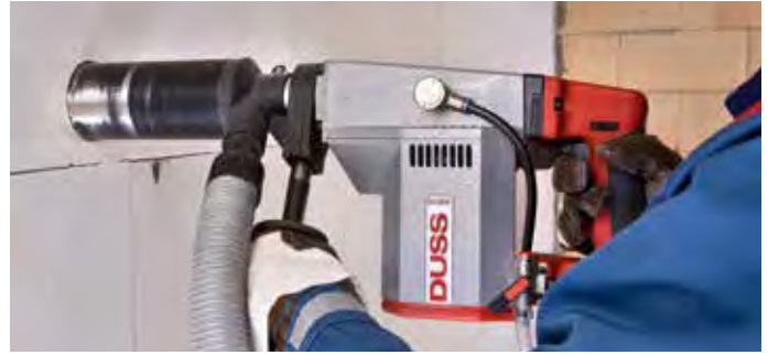
Dosensenken trocken in Kalksandstein mit Staubabsaugung
