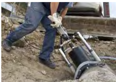
ANBOHREN VON BETONROHR – nass, stativgeführt
