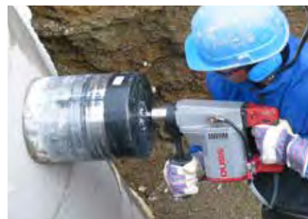
ANBOHREN VON BETONSCHACHT – nass, handgeführt
