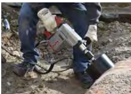
ANBOHREN VON KUNSTSTOFFROHR – trocken, handgeführt
