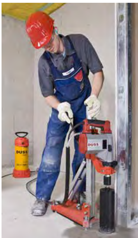
NASSBOHREN in Beton – ständergeführt
