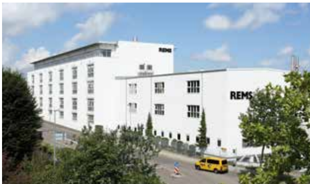
REMS Schulungszentrum in Waiblingen bei Stuttgart.
